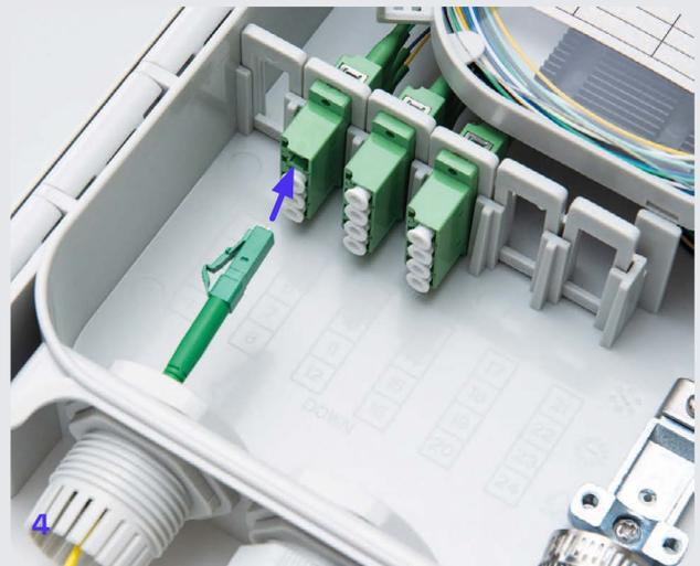
1. Öffnen Sie das Gehäuse des Glasfaser-Abschlusskastens. Entfernen Sie die Schutzkappe der Steckverbindung, des sogenannten „Ports“, der in unserem Anschreiben **„Technische Daten zu Ihrem Internet-Zugang“** angegeben ist. In der Abbildung wurde die Schutzkappe von Port 1 / rote Faser entfernt. Sollte in Ihrem Schreiben ein anderer Port angegeben sein, finden Sie die Farbcodes auf Seite 10.
